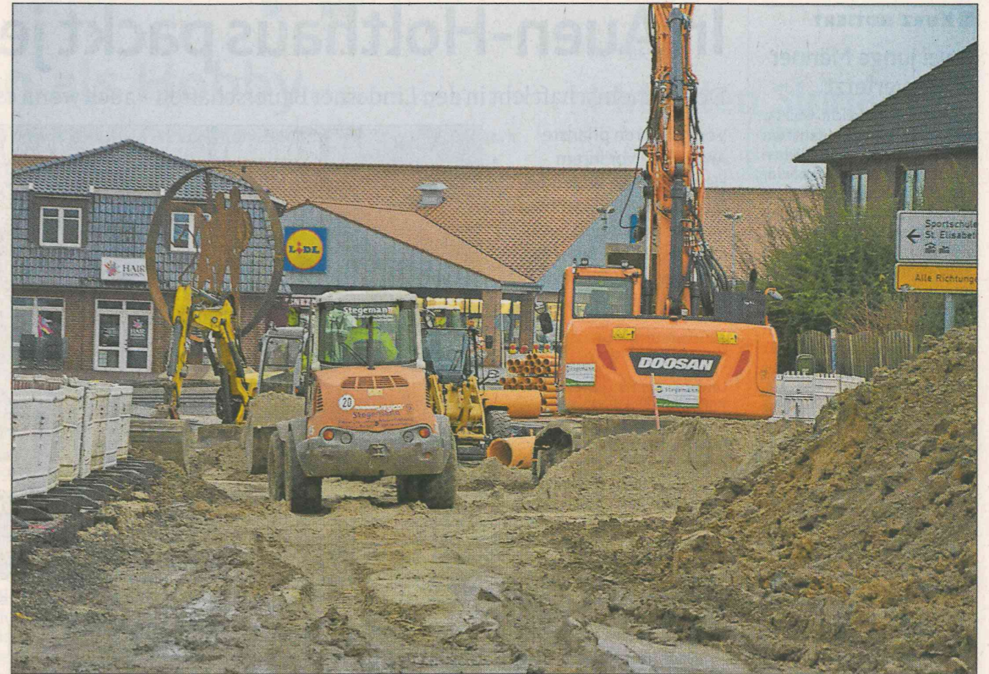
Großprojekt: Die Sanierung der Vlämischen Straße in Lastrup hat begonnen.
